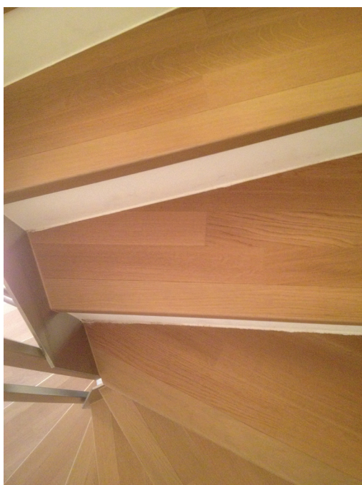
Nez de marche et contremarche arrondis sur demande. Trittstirnkanten und Gegenstufe gerundet auf Anfrage.
