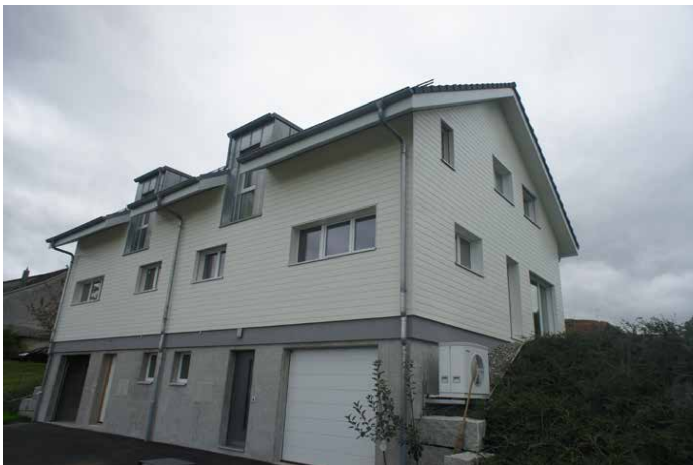
Lame „Sapinat“ épicea abouté, poncée, finition „Dakota“ RAL 9010 Täfer „Sapinat“ Fichte keilgezinkt, geschliffen, Endbearbeitung „Dakota“ RAL 9010
