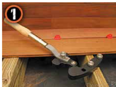
1 Positionnez l'outil Hardwood Wrench™ sur la sous-construction. Setzen sie die Hardwood Wrench™ auf die Unterkonstruktion an.
