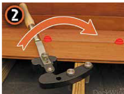
2 Tournez la poignée afin d'aligner la lame. Drehen sie den Griff, um die Dielen auszurichten.
