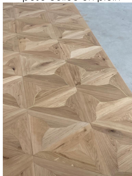
pose collée en plein
